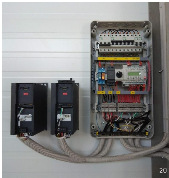
Монтаж щитов управления
